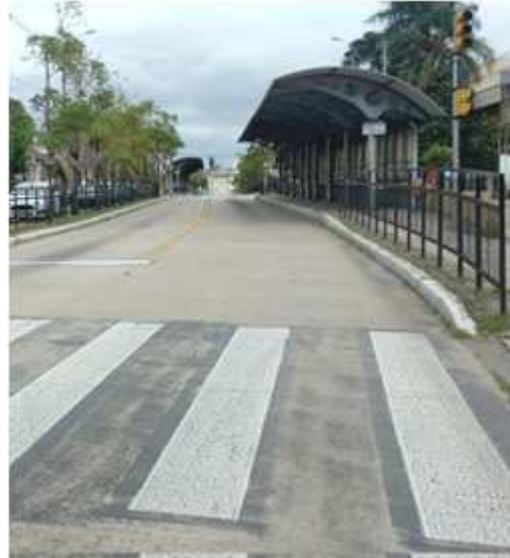
Figura 51 – Corredor de ônibus da 3ª Perimetral. Fonte: Banco de Imagens - PMPA.
