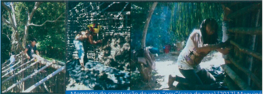
Momento de construção de uma "opy" (casa de reza) [2017] Maquinê
